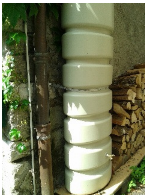
Cuve de récupération des eaux de pluies
