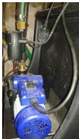
La pompe qui permet de remonter l'eau.
