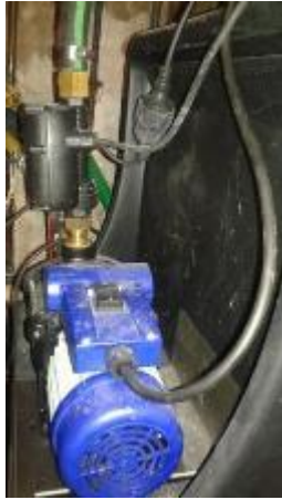
La pompe qui permet de remonter l'eau.
