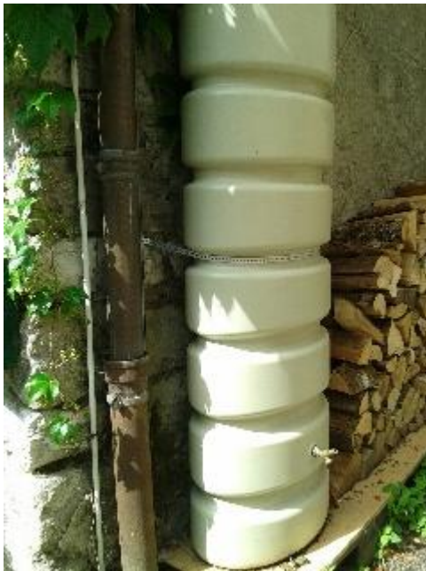
Cuve de récupération des eaux de pluies
