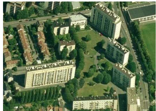
Résidence Vauban, rue Vauban/ rue Champ Lagarde
