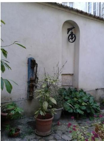
Puits ancien avec margelle encore existante transformée en jardinière. Roue et treuils visibles, pompe installée ensuite pour le confort des habitants.
