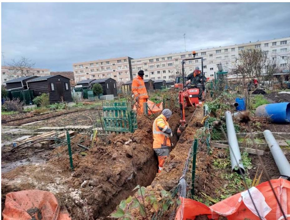
Ouverture de la tranchée dans l'allée principale et pose du tuyau de 300
